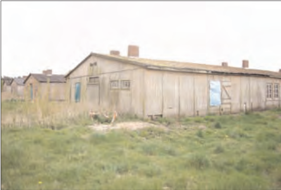
Ehemalige Unterkuftsbaracke „z4“ (Nutzung als Depot der Gedenkstätte)
