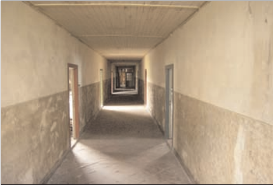
Nachlagerzeitliche Raumaufteilung der hölzernen ehemaligen Unterakunftsbaracken durch massive Flurwände
