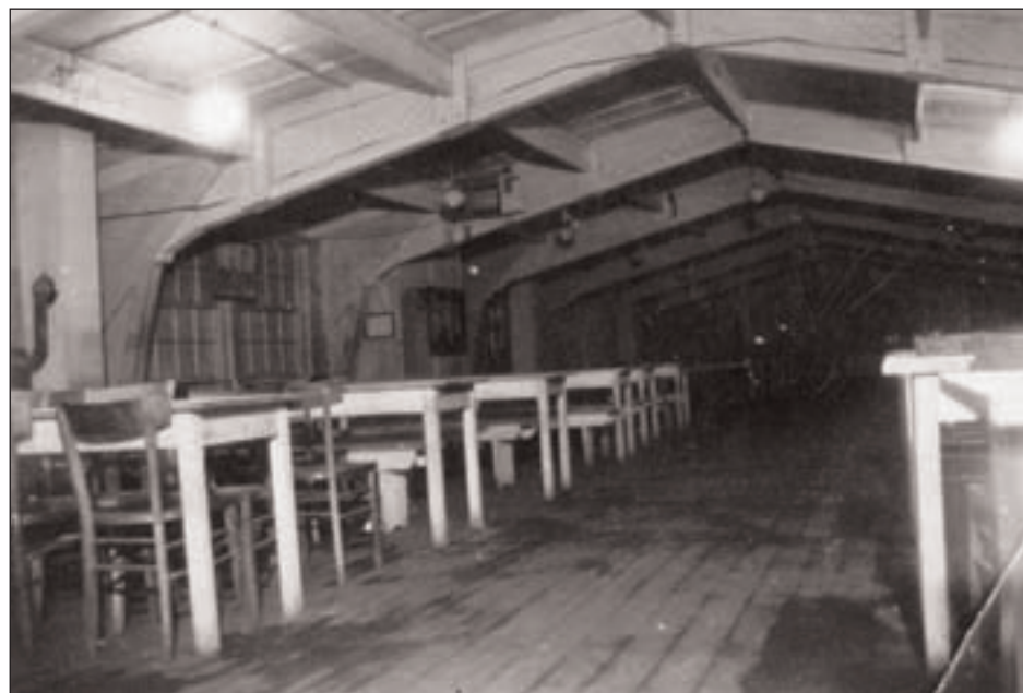
Das Innere einer Baracke, offenbar der Esssaal
