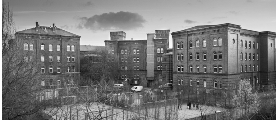
Abb. 3: Block III von der Hofseite; Zustand vor den größeren Baumaßnahmen (2015; Foto: Jakob Borner).
