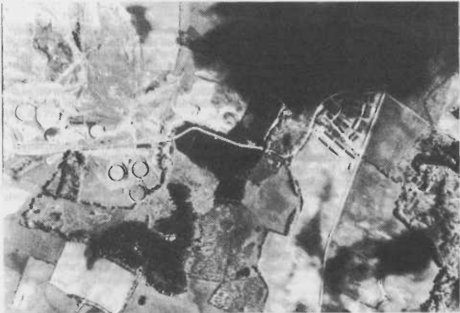
Das Lager Jägerlust in einer Aufklärungsaufnahme der Royal Air Force aus dem Mai 1944. Nördlich des Lagers sind die teilweise noch im Bau befindlichen Ölbunker zu erkennen (RAF photography mit der freundlichen Genehmigung des Ministry of Defence, London - D/CS [PS] 10/9-3 [565] - British Crown © ).
