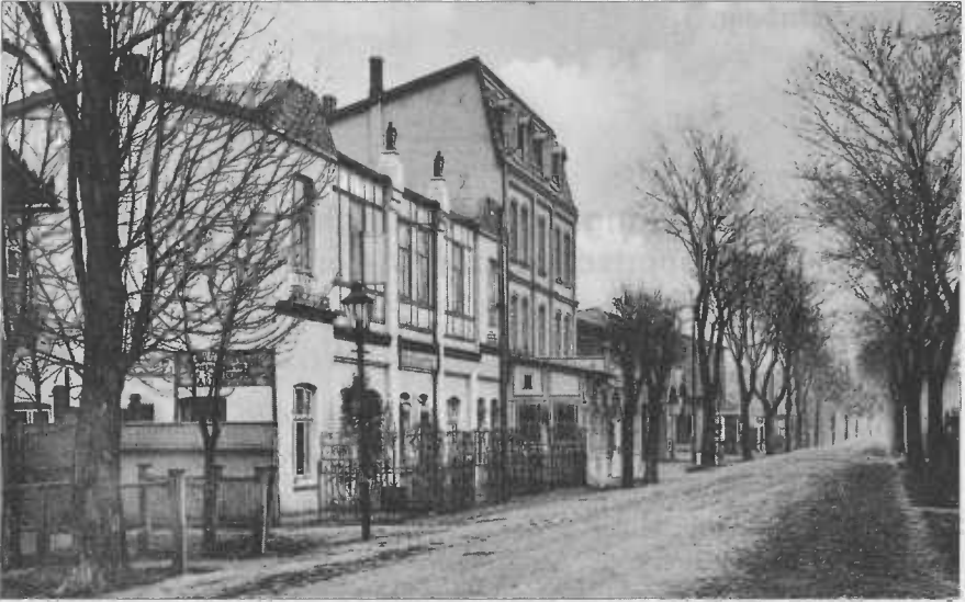
Abb. 1: Das Gebäude der Volkssportschule in einer Aufnahme aus der Kaiserzeit
