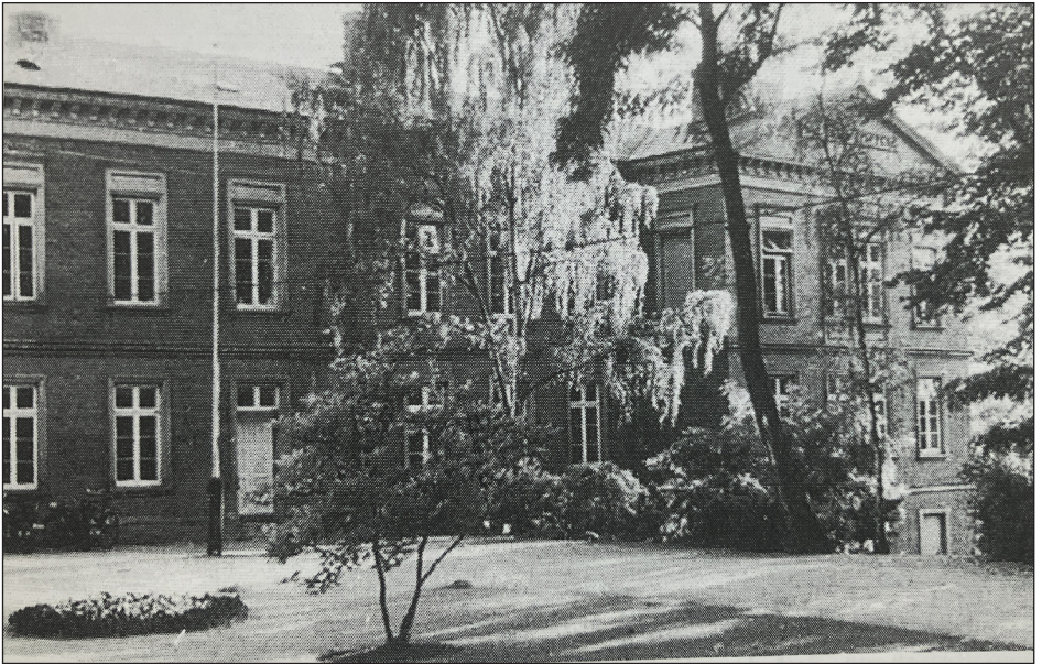
Kreiskrankenhaus Eutin: Hier wurden über 50 Abbrüche durchgeführt
