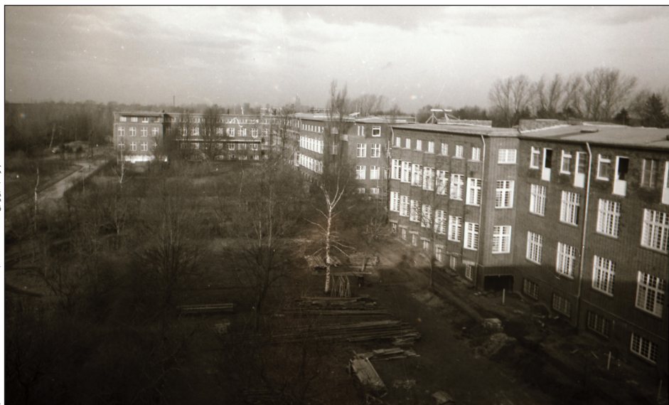
Städtisches Krankenhaus Ost, Lübeck: Hier wurden hunderte Abbrüche durchgeführt
